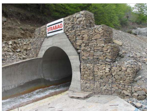
Слика 56 Обиколен тунел на хидројаловиште бр.4
