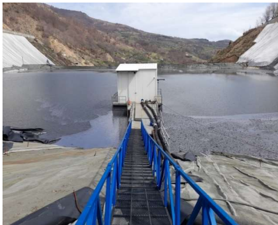
Слика 59 Пумпна станица со потисна линија хидројаловиште бр.4
